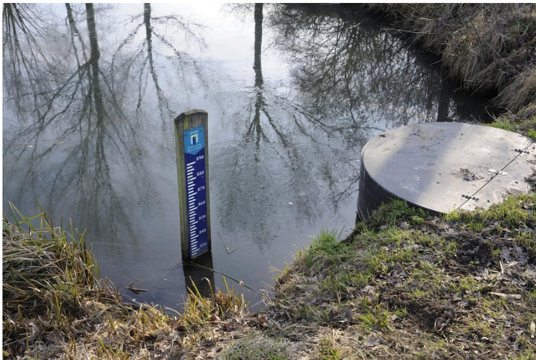
Riooloverstort (foto: GAW/Stichting RIONED).
